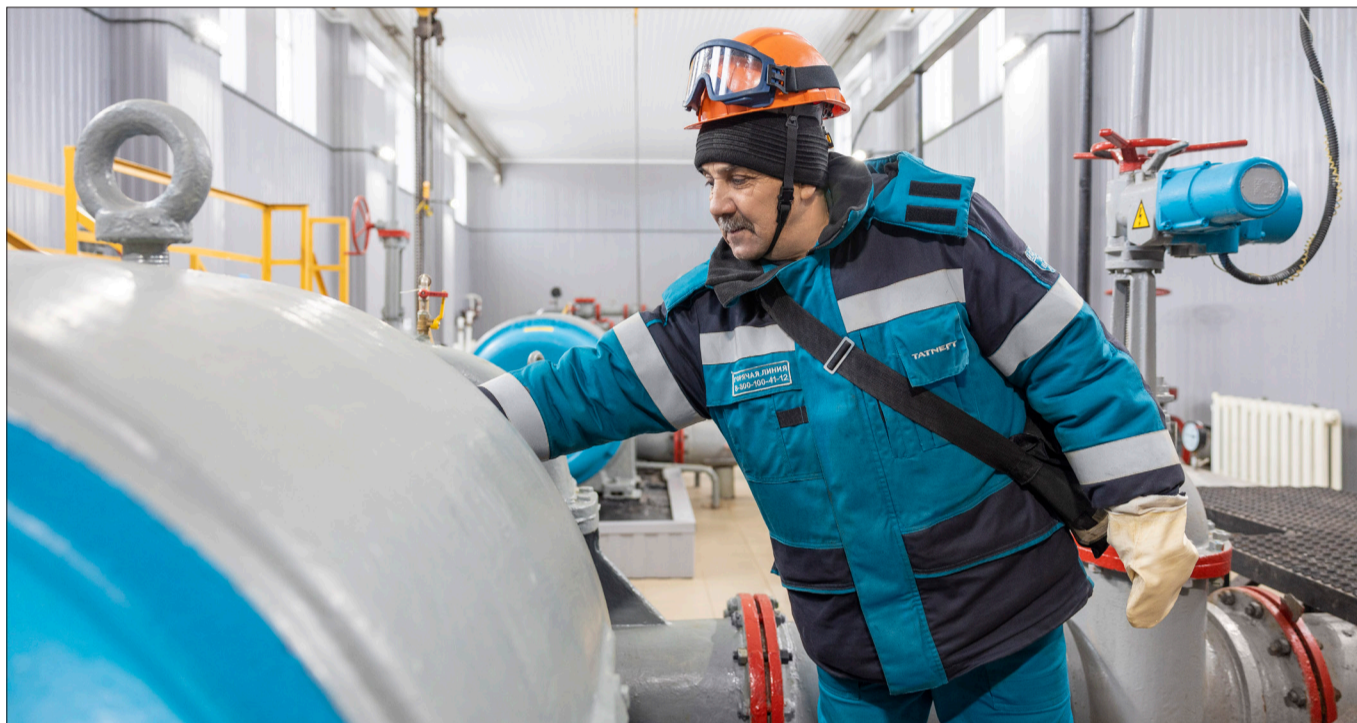
Наиль Кадермитов следит за поддержанием порядка и культуры производства на ЛДНС с УПСВ / фото СЕРГЕЯ ТРУСОВА
